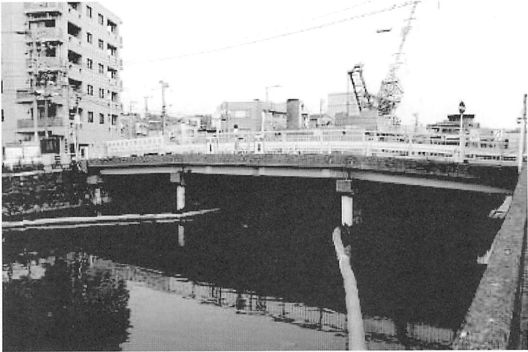
写真-3.2.2 根岸橋現況（旧橋）写真（上流側：2005年6月）
