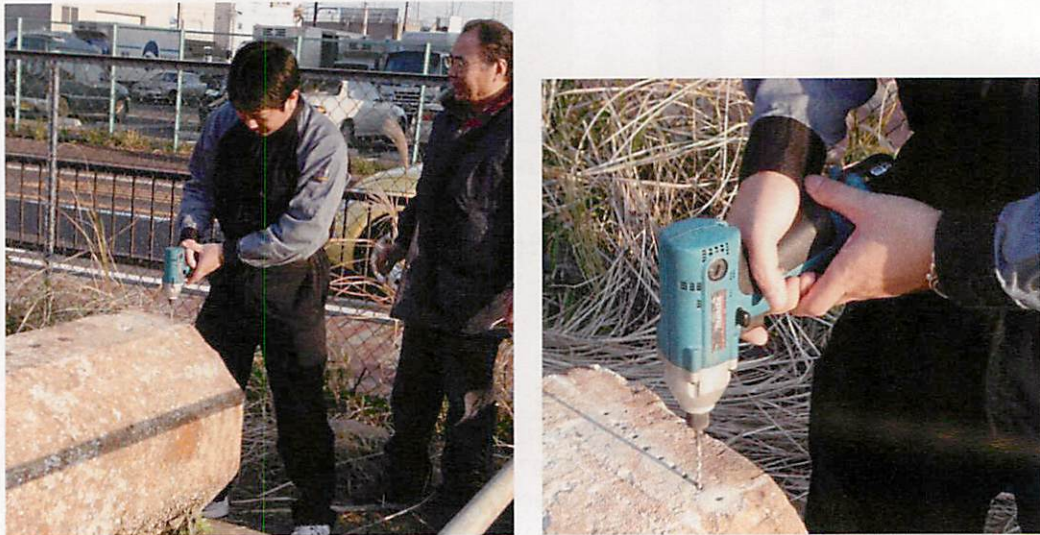
写真-4.4.5.1 塩化物量測定用試料採取状況
