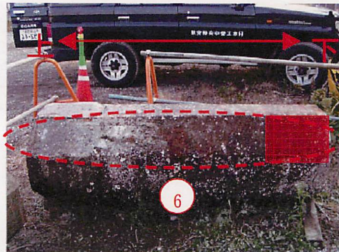
図-5.3.1.5 自然電位評価位置(右岸 P2橋脚下部)
