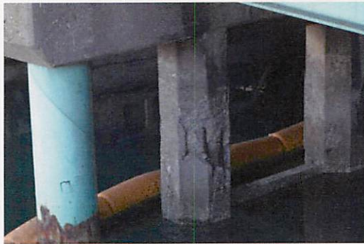
写真-4.3.1.5 根岸橋の外観 3
