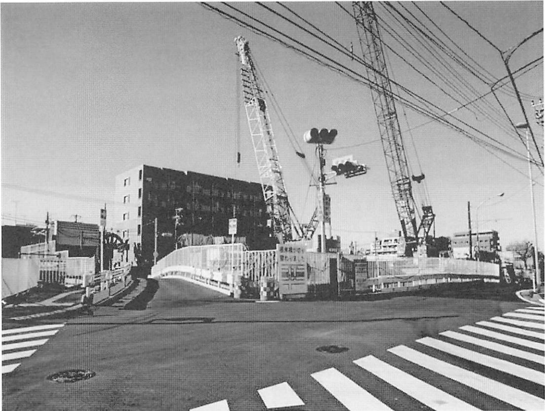
写真-3.2.3 根岸橋現況（新橋）写真（左岸側：2007年1月）
