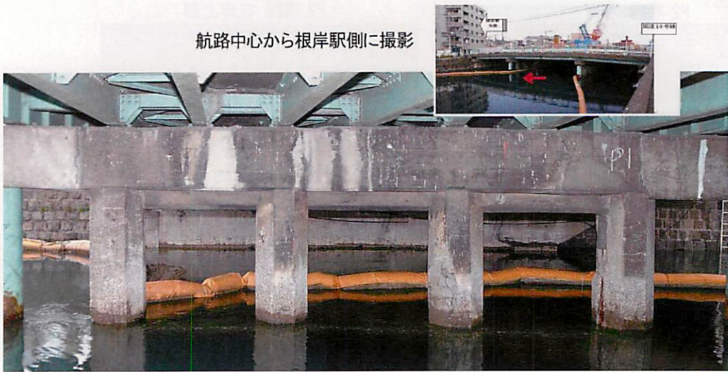
写真-4.3.1.3 根岸橋の外観 1
