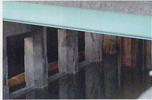
写真-4.3.1.6 根岸橋の外観 4
