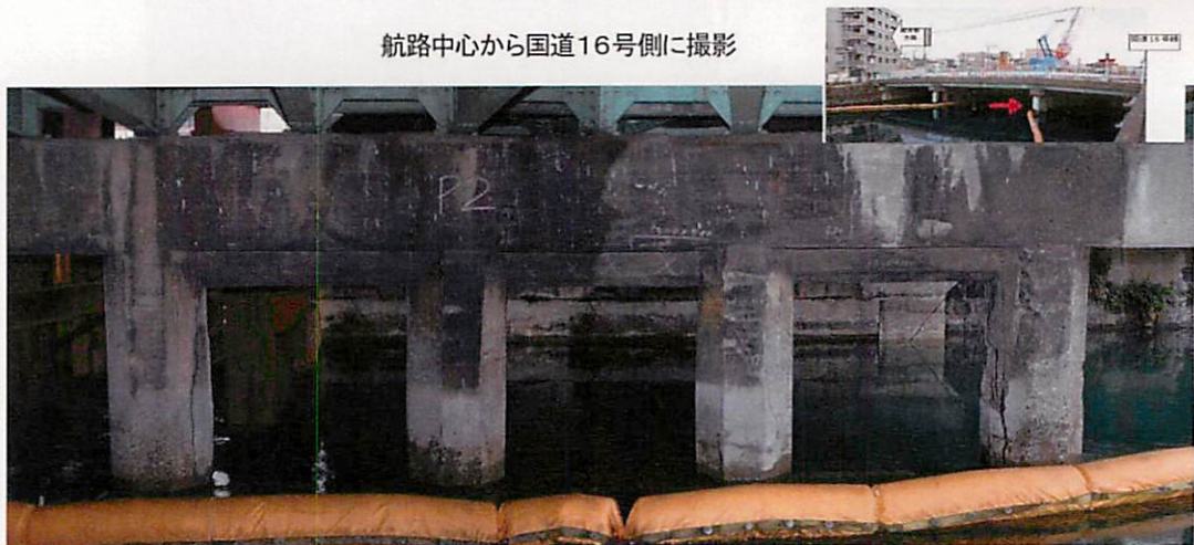
写真-4.3.1.4 根岸橋の外観 2
