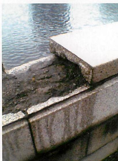
写真-3.3.2.4 欄干御影石張りの破損
