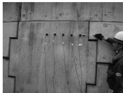
調査位置②の測定状況
