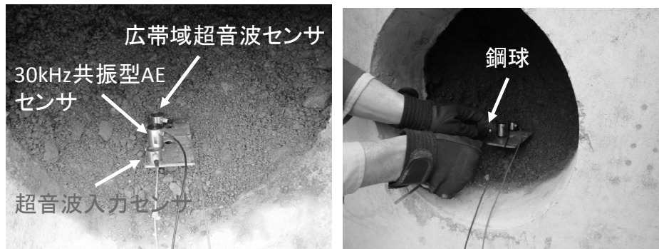
写真 3.1 センサの取付け状況
