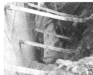
盛土材のすり抜け
