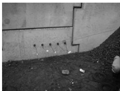
調査位置①の測定状況
