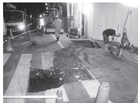
写真-事例 3.3, 3.4 その他地下埋設物起因による陥没事故発生例(バス脱輪)
