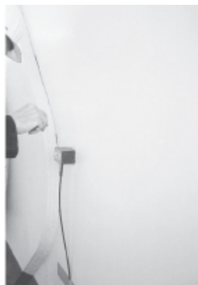
石油タンク側板に取り付けられた AE波センサー AE wave sensors attached to the shell plate of an oil tank
