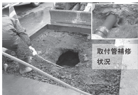
写真-事例 3.2 開削状況
