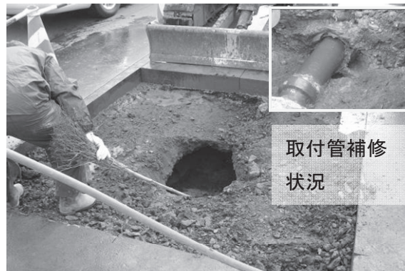
写真-2.2 路面下空洞の例 4)
