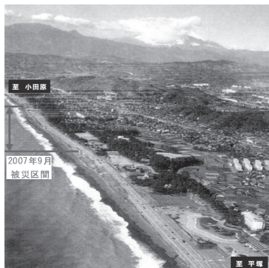
写真-3.2.3.1 西湘バイパス建設当時の写真
