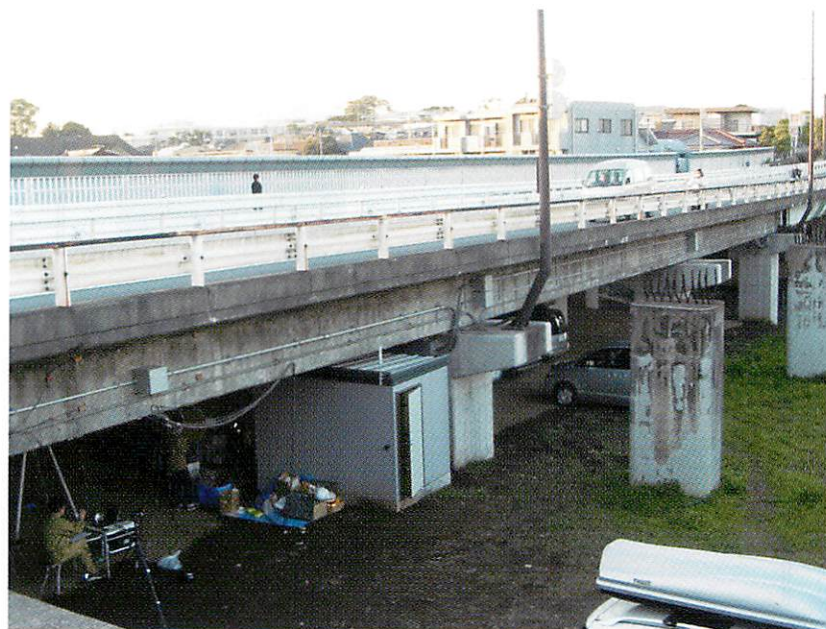
写真 3.1-1 モニタリング対象橋の外観
