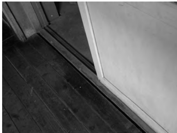
写真 2.4.2.2 建物のずれ、約 20mm.
