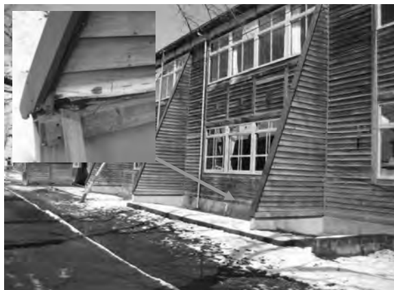
写真 2.2.3.2 バットレスの損傷状況
