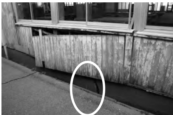
写真 2.4.4.2 基礎の破壊
