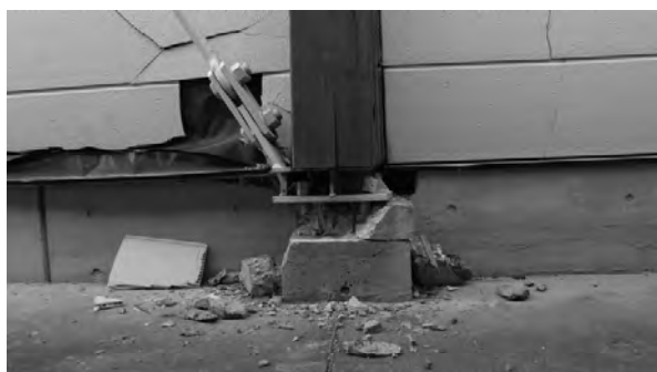
写真 2.3.3.2 コンクリート基礎の破損
