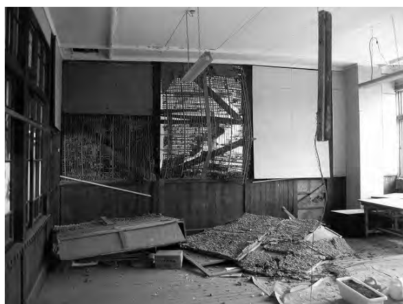
写真 2.2.3.3 土壁の破壊状況
