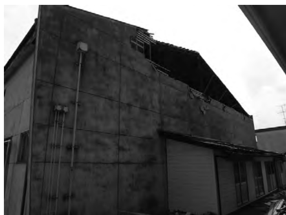
写真 2.3.2.2 妻壁の被害
