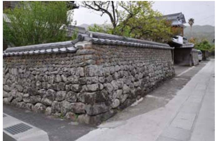
高知県室戸 防風石垣
