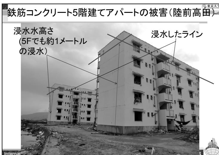
この写真は陸前高田市のRC5階の建物ですが、5階まで上がってみると、5階でもおよそ1mの浸水の跡が残っています。
