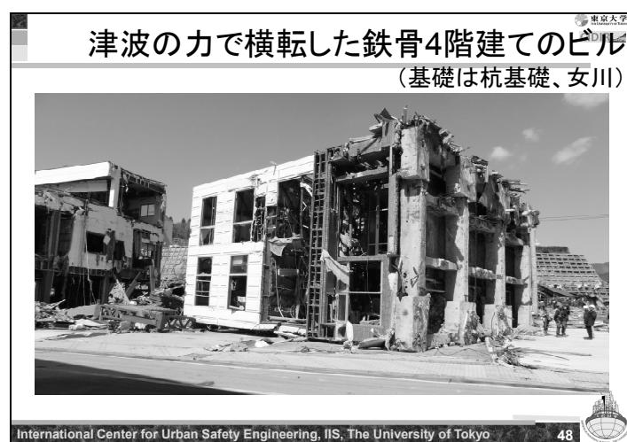
これはその事例で、女川町での基礎杭を持った4階建て重量鉄骨造が転倒した事例です。杭を打っていた建物の杭が引き抜けたり、杭頭がちぎれたりして転倒している事例です。
