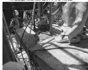
煉瓦壁に鉄筋を挿入し補強
