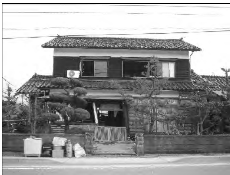
写真 10 能登半島地震における被害例（蓮田の埋め立て地）
