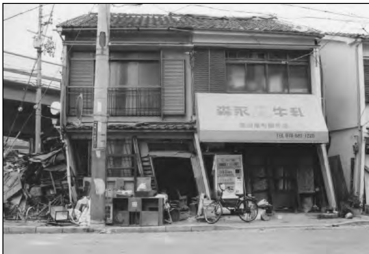
写真5 兵庫県南部地震における被害例－2（店舗併用住宅）
