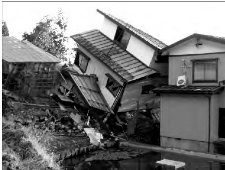
写真 1 1 中越地震における被害例－3（地盤崩壊）
