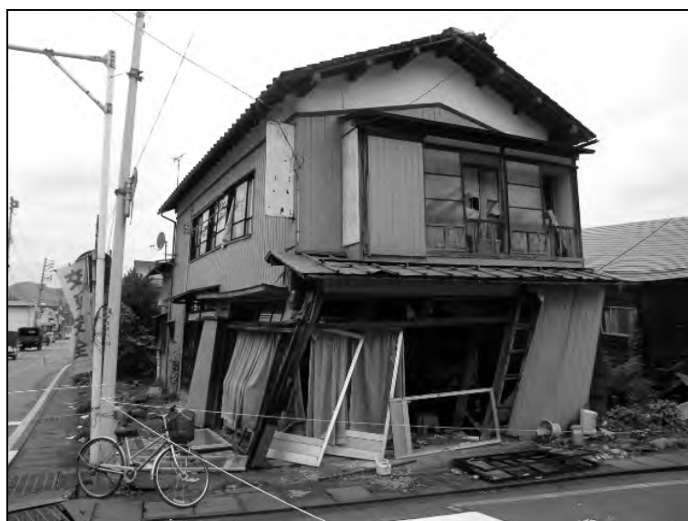
写真7 中越地震における被害例－1（店舗併用住宅）
