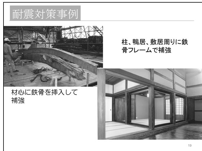
それから、個別の建物修理のときの補強の例では、例えば梁の中に鉄骨を入れる、あるいは建具周りを鉄骨フレームで補強するなど、いろいろなことをやっています。
