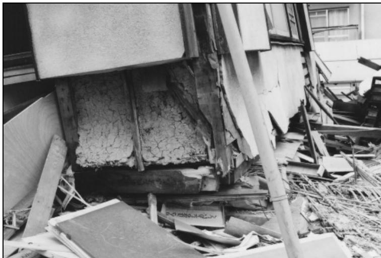
写真4　写真3の建物詳細（通し柱の折損）
