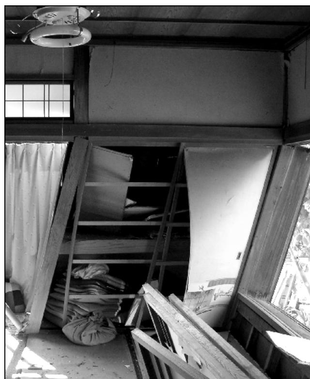
写真 8 中越地震における被害例－2 (柱の折損)
