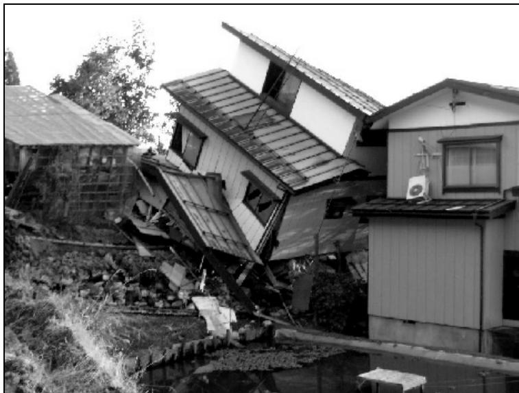
写真 1 1 中越地震における被害例－3（地盤崩壊）
