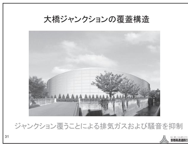
図-3.27 高架構造から地下構造移行区間の環境対策 事例 2
