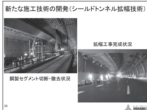
図-3. 23 拡幅箇所の施工中と施工後
