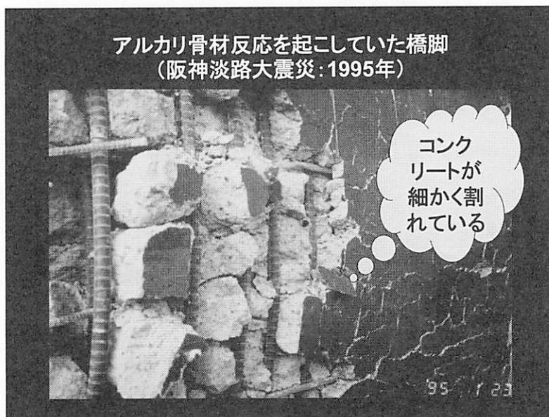
図-2.4 アルカリ骨材反応を起こしていた橋脚
