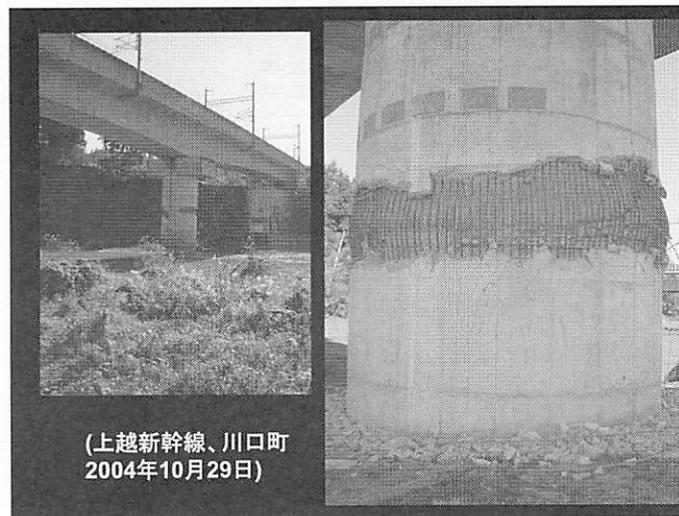
写真-2.2 中越地震で損傷した新幹線の橋脚
