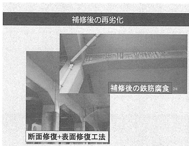
図-2.51 補修後の再劣化
