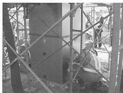
薄板取付け状況①
