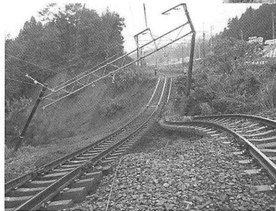
図-2.21 盛土の損傷
