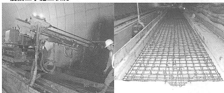
側壁部ロックボルト打設状況
