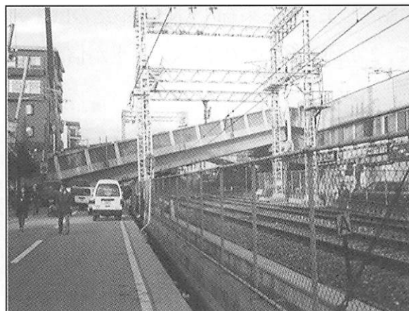
図-2.16 PC 桁の落橋
