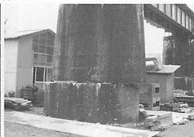
図-2.22 魚野川橋梁の損傷
