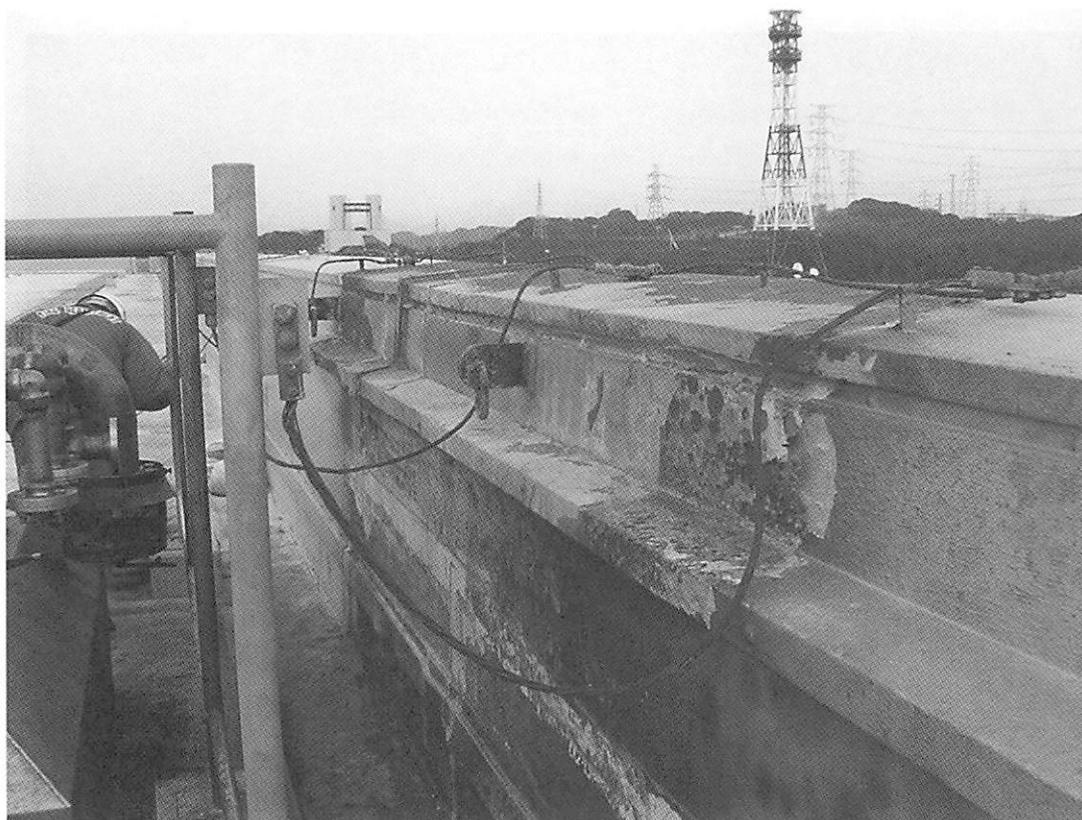
写真-3.8 タービン建屋屋上被害状況
