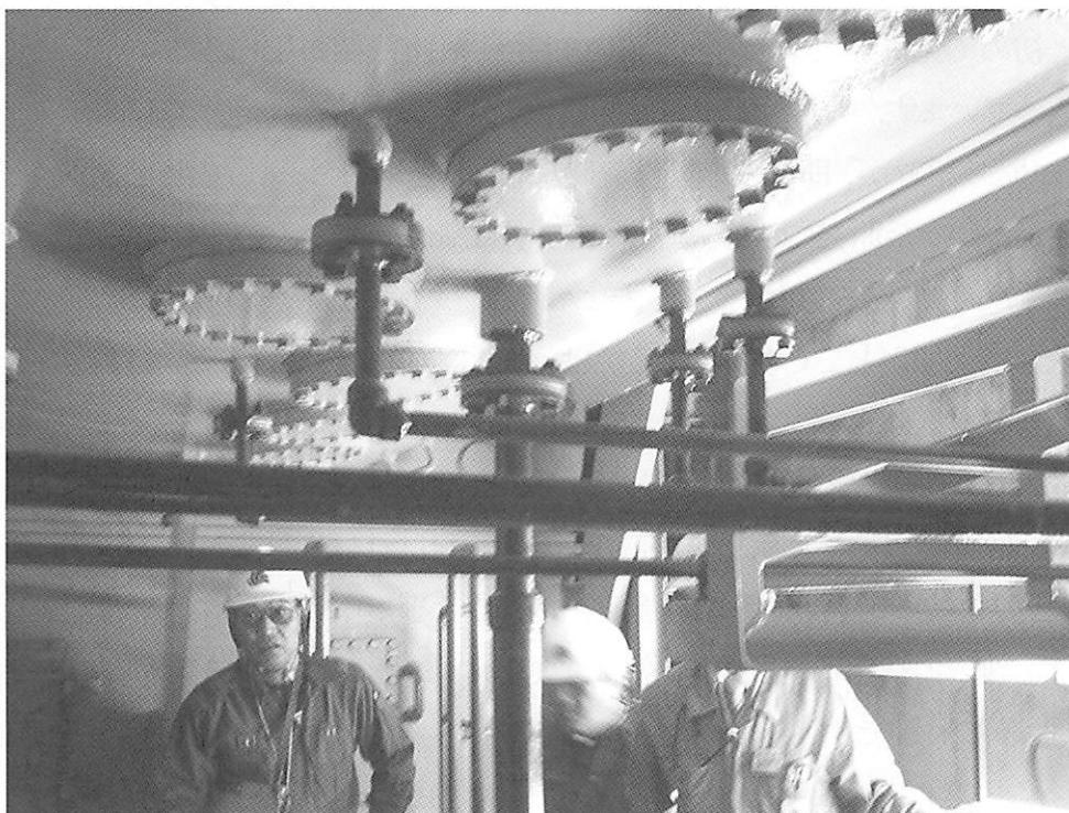
写真-3.10 発電機下の水素配管
