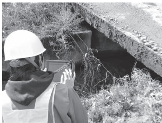
写真-1 タブレット端末による小規模橋梁点検試行
