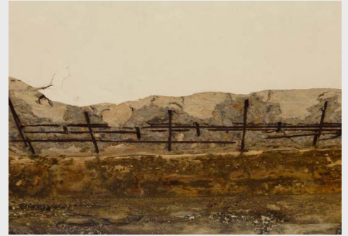
ミャンマーにおけるコンクリート構造物の劣化調査
