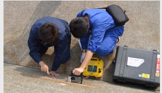
海岸構造物のひび割れ調査
