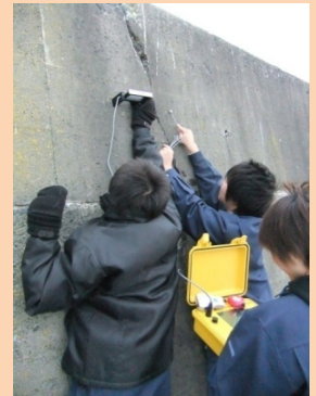
海岸構造物の老朽化調査
