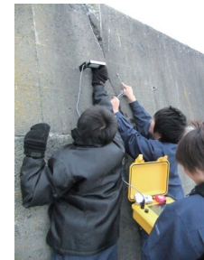
防波堤の劣化度調査
