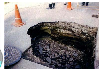
下水管の破損に伴う道路陥没
