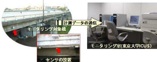
コンクリート橋の モニタリング
