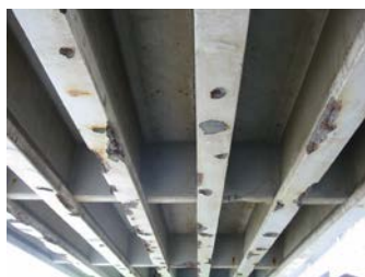
劣化構造物調査
